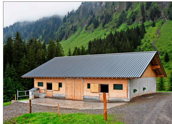
Der neue Stall mit eingebauter Rohrmelkabsauganlage auf dem unteren Stafel bietet Platz für 42 Tiere.
